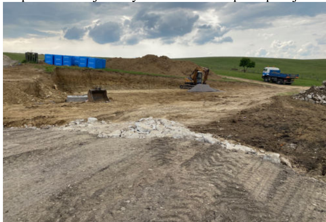
Odkop terénu, príprava na osadenie stavby
