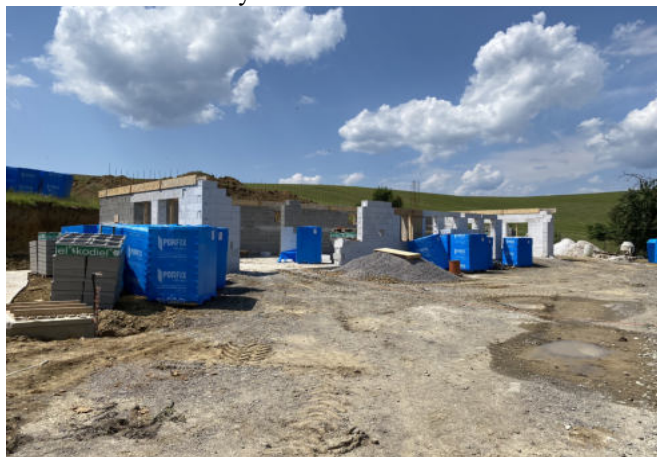
Vymurovaný zadný múr aj s vencom, murovanie obvodových
